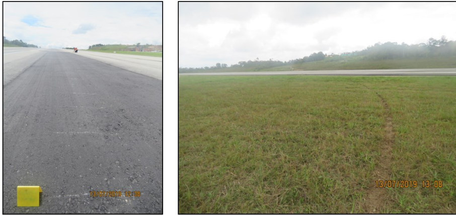
Fotos No. 2 y 3: Marcas en la pista y en la zona de seguridad
