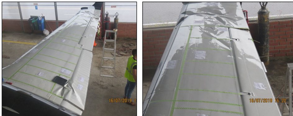
Fotos No. 4 y 5: Mapeo de daños estructurales del plano derecho
